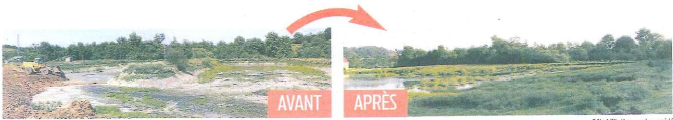
Réhabilitation, par le procédé de construction de sol, d'une lagune industrielle.
