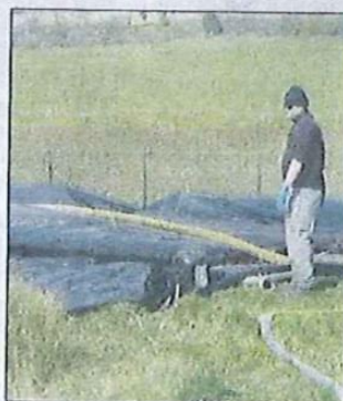
... de les stocker dans des géotubes.
